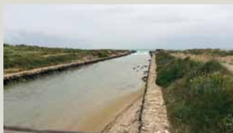
19. Canale di collegamento al mare.
