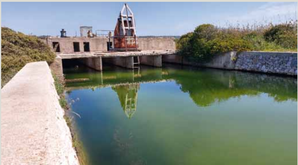
18. Opere di presa dell'ex Impianto di acquacoltura Ittica di Ugento, al bacino.
