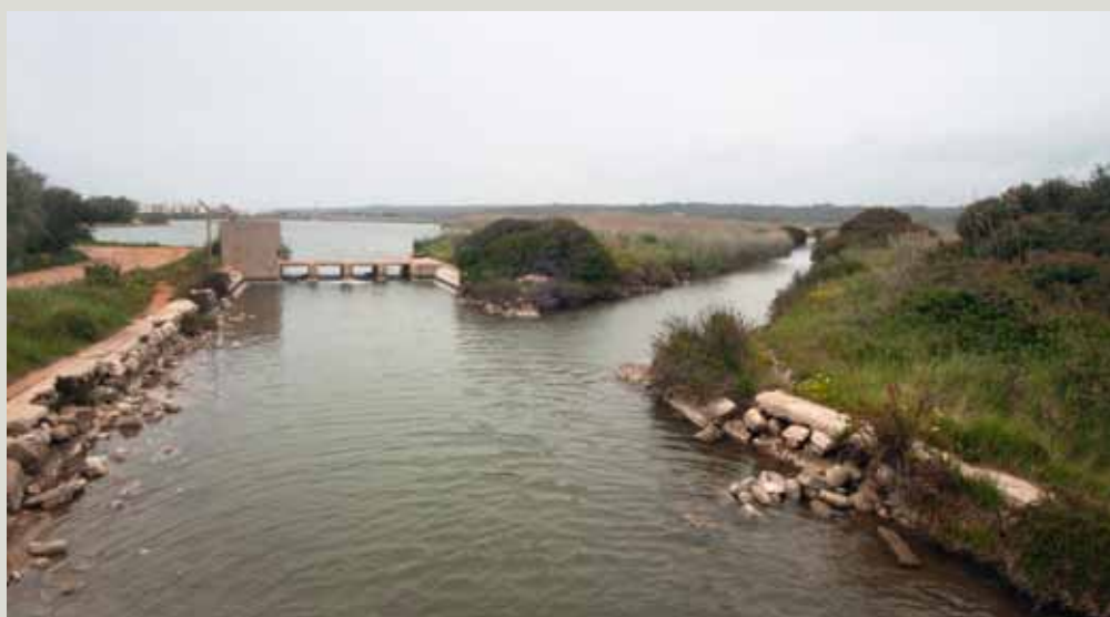
20. Canale di restituzione delle acque provenienti dall'ittica, che intersecano il canale di collegamento tra i bacini Spunderati Nord e Spunderati Sud.
