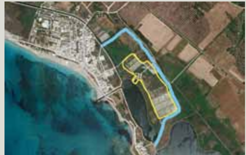
21. Localizzazione dell'ex-impianto di acquacoltura, confini (area perimetrata in giallo) e collettore di adduzione e restituzione delle acque (percorso in blu).
