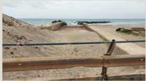
17. Prima parte del canale che collega il bacino al mare, parzialmente occluso da sedimento sabbioso.
