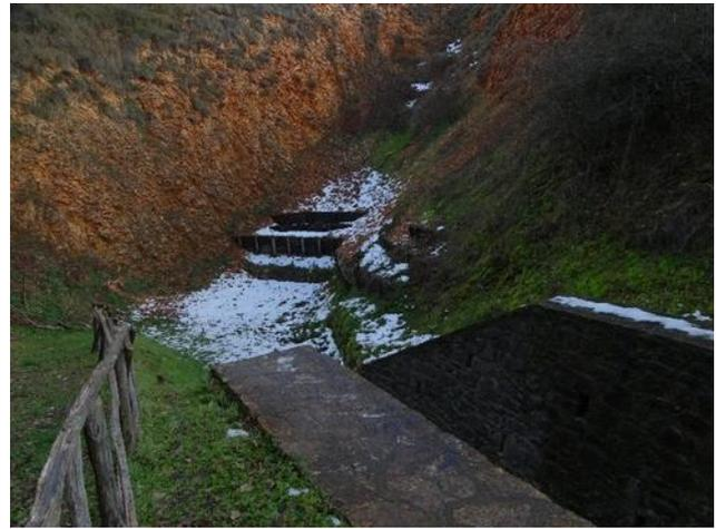
**Figura 1** – Soglia in muratura che regola l'altezza del livello d'acqua della Palude di Colfiorito (foto sinistra); l'acqua in eccesso confluisce nell'Inghiottitoio del Molinaccio (foto destra).
