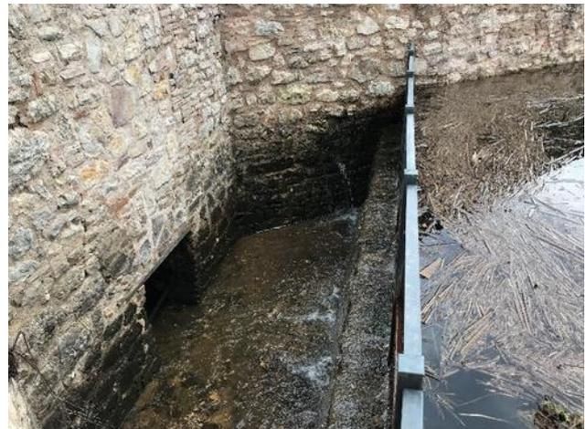
**Figura 3** – Idrometro per la misura del livello dell'acqua, costituito da un'asta idrometrica e da una sonda idrostatica (foto a sinistra) che invia i dati ogni 12 ore. Il sistema consente di monitorare il livello dell'acqua riferito alla soglia di sfioro dell'inghiottitoio, dove si può accumulare materiale vegetale che alza il battente idraulico (foto a destra).
