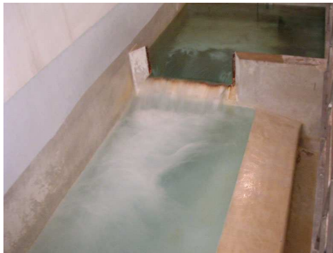
Figura 4 – Sfiatore lineare per la separazione del contributo captato da quello rilasciato nell'alveo del fiume Menotre .
