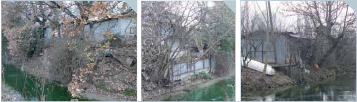
Fig. 5.1.1 – Esempi di strutture realizzate a ridosso del fiume Clitunno .
