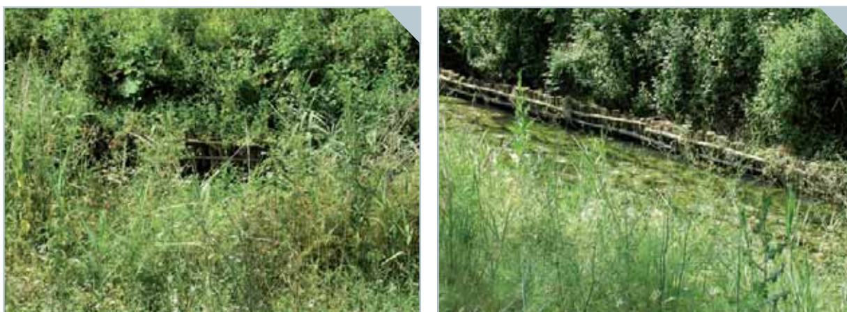
Fig. 3.4.2.17 – Consolidamento della sponda sinistra del torrente Teverone con palizzate.
