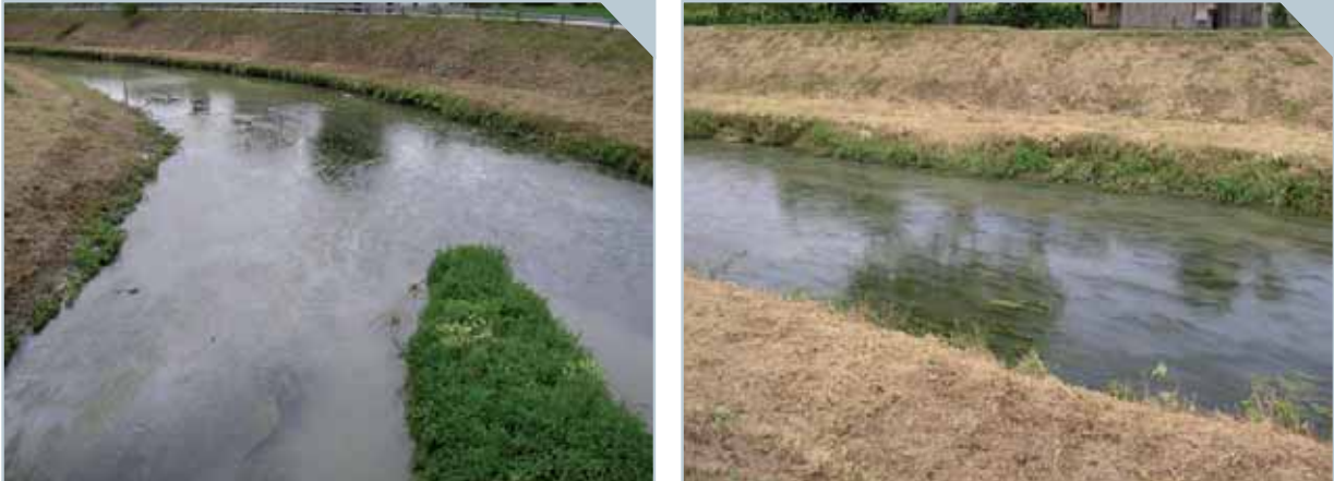
Fig. 3.4.2.4 – Torrente Timia: sponde soggette a sfalciamento con interruzione del canneto.
