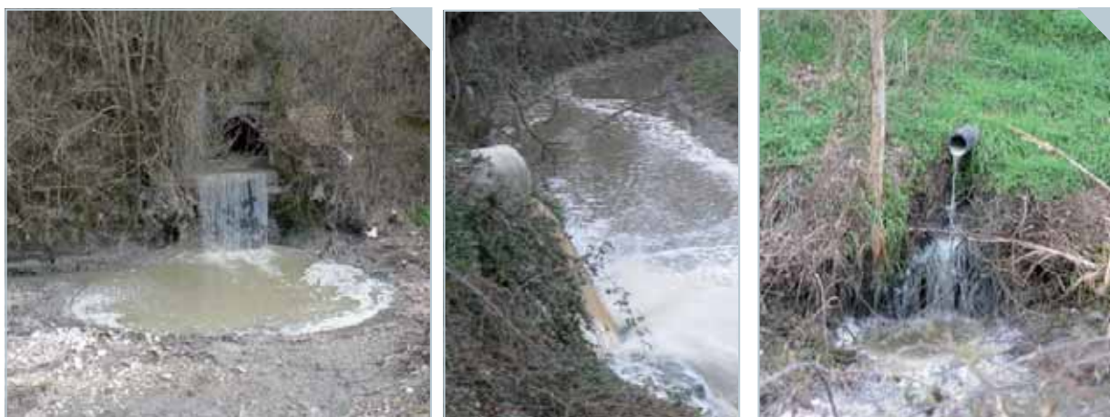
Fig. 5.2.1.1 – Impatto ambientale degli scarichi di tipo civile sul torrente Marroggia: scolmatore di piena posto a monte dell'impianto di Campo Salese (attivo anche in assenza di precipitazioni atmosferiche), scarichi del depuratore di Campo Salese e del depuratore di Campello sul Clitunno.
