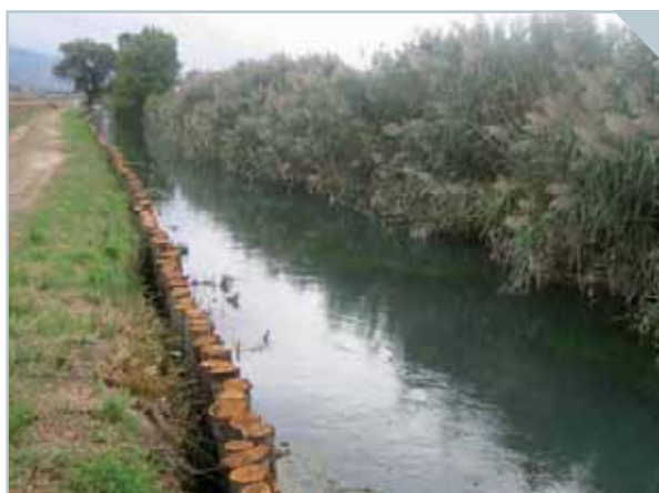
Fig. 2.4.3.3.18 - Esempio di sponda fluviale priva di vegetazione riparia in cui è stata realizzata una palizzata.
