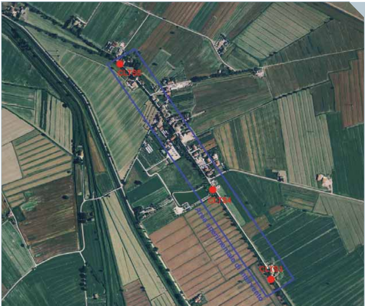
Fig. 2.1.3.2.1.1 – Localizzazione dell'area sperimentale di intervento ove effettuare eventuali azioni di rimozione del sedimento fine. I cerchi rossi indicano i punti di prelievo dei campioni di sedimento utilizzati per verificare la possibilità di riutilizzo del materiale.
