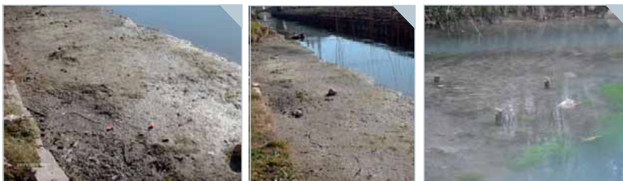
Fig. 5.1.1.3 – Depositi di sedimenti fini ubicati nell'abitato di Casco dell'Acqua.
